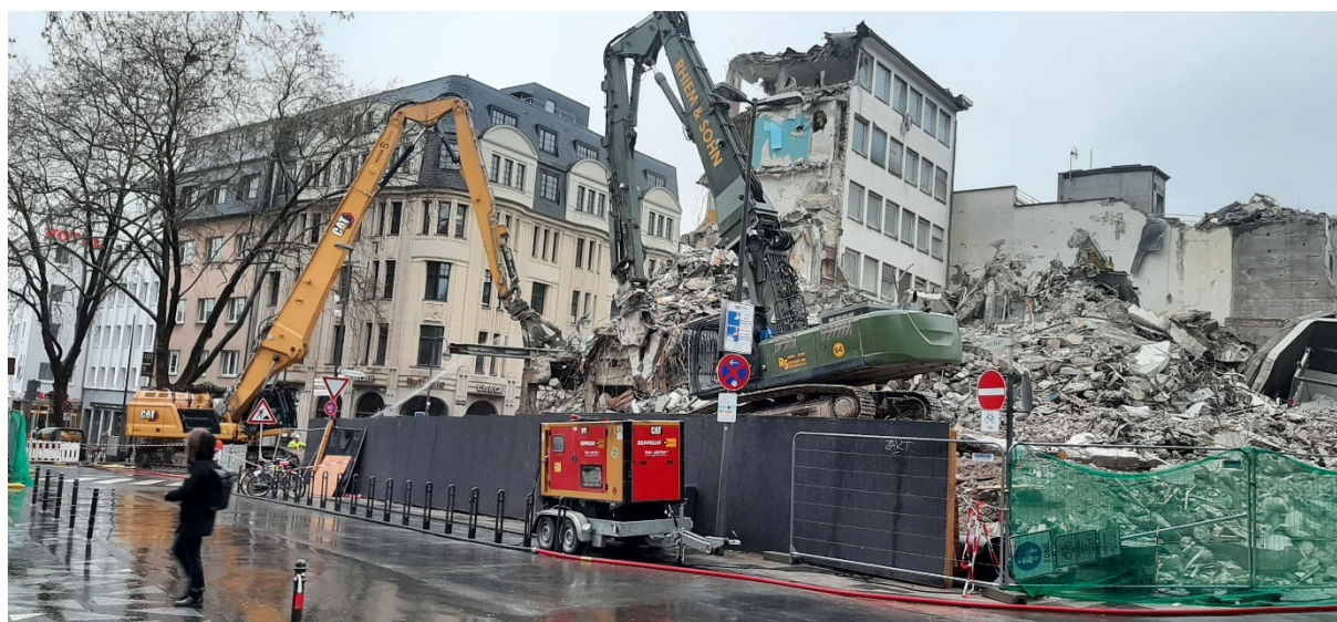
Abbildung 1: Baustelle in Köln 7
